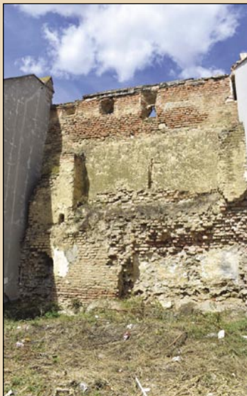
Úsek hradby pri severovýchodnej nárožnej veži v roku 2020, pred obnovou
