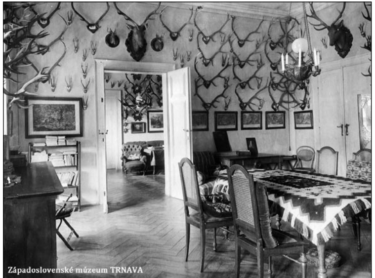
Obytné priestory na poschodí kaštiela v Dolnej Krupej, zdroj: https://kastieldolnakrupa.sk/kastiel#gallery-6
