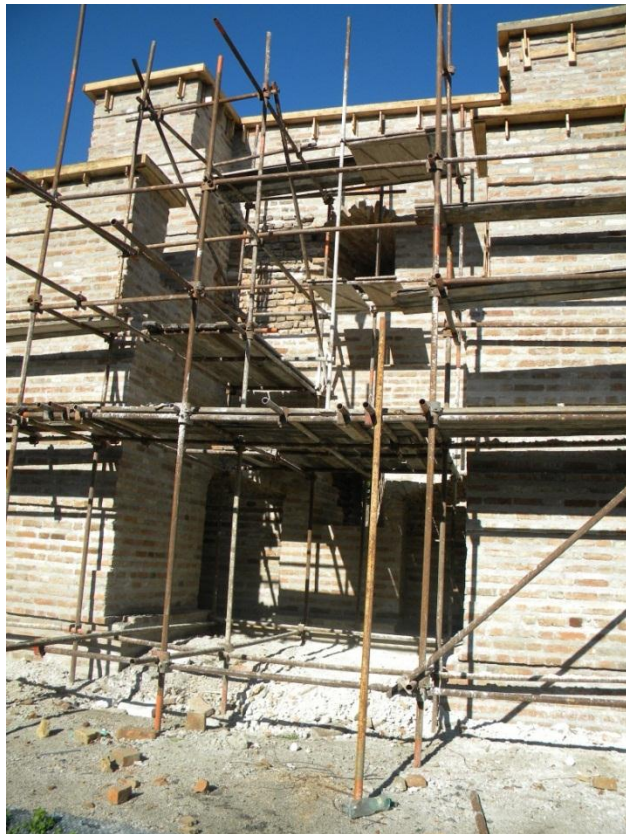
Sanácia a rekonštrukcia veže, stav október 2014
