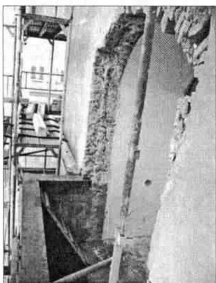
Obr. 5. Otvor priechodu do arkiera po odstránení zámuroviek
