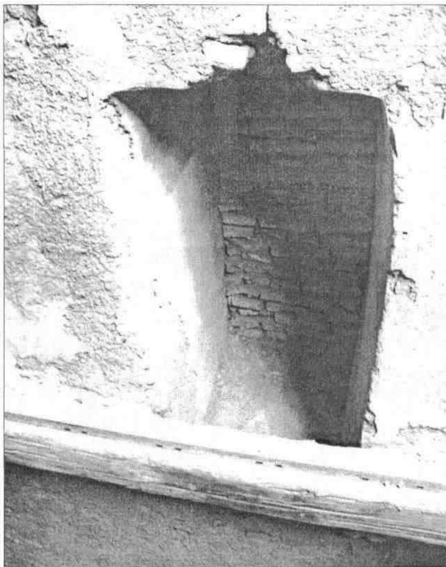
Obr. 7. V súčasnosti zamurovaný otvor severnej steny svätyne v podkroví
