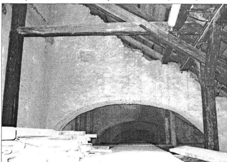
Obr. 4. Oblíukové operáky v podkroví južnej bočnej lode
