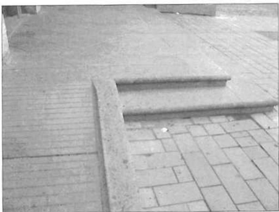
Obr. 3. Obnova vchodu do Kostola svätého Jakuba (st.). Rampa a schody vyrobené z dobrovodskeho kameňa, foto: autorka
