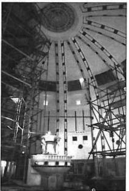
Obr. 5. Irma, bahnisko, mreža prekryvajúca oculus, v minulosti odstránená, bola vyrobenná podľa dobovej dokumentácie. Každý z maskarónov, lemujúcich rebrá nosnej konštrukcie, má iný výraz
