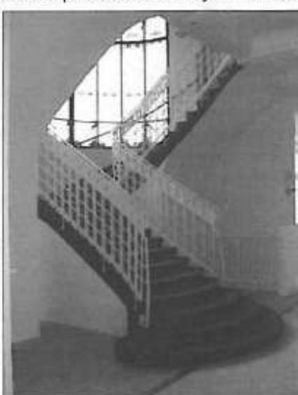
Obr. 4. Irma, schodište vstupnej haly po obnove, celé zábradlie je kvôli dnešným normám zdvihnuté
