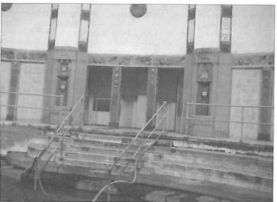
Obr. 9. Irma, bahnisko, spodná časť pred obnovou. Po odstránení zámurovky nik (vpravo aj vľavo na obrázku) boli zistené stopy po osadení kovových dverí
