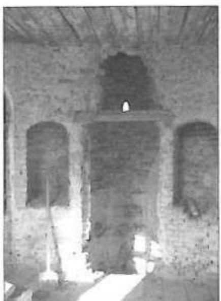
Obr. 14. Stena miestnosti poschodia s nikami a vstupom zo severného schodiska po odstránení jebo zámurovky
