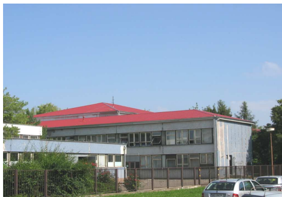
rekonštruovaná strecha, ZŠ K. Mahra
