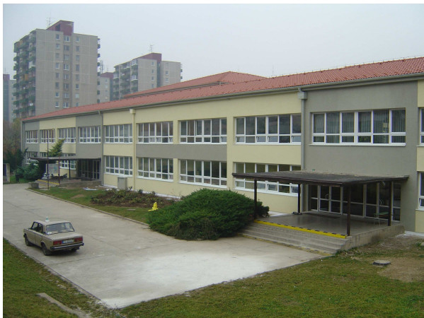
Základná škola Spartakovská po rekonštrukcii
