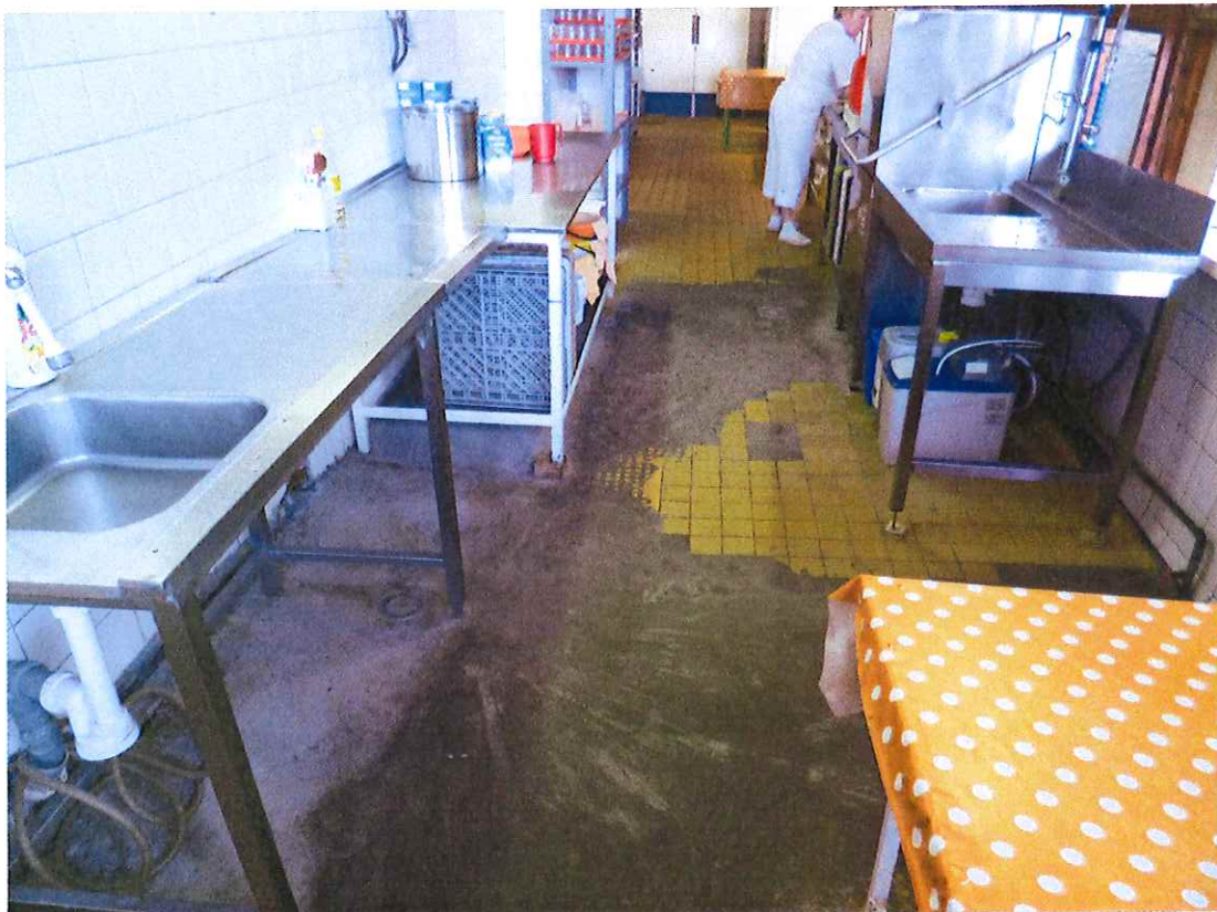
6/ PODLAHA PO OPRAVE KANALIZÁCIE 9/2015
