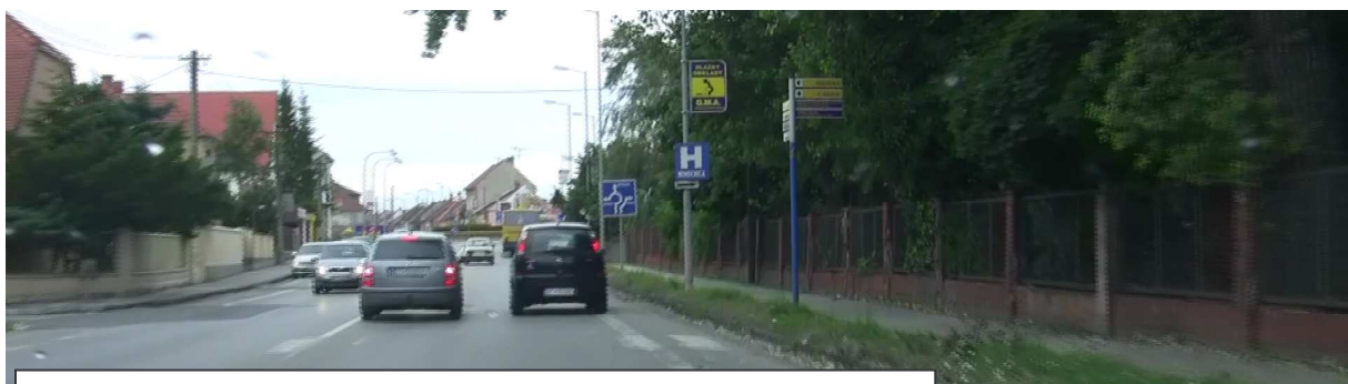
Príklad obchádzania vozidla odbočujúceho vľavo (do Kozáckej ul.) Zvyšky priechodu pre chodcov zneisťujú vodičov
