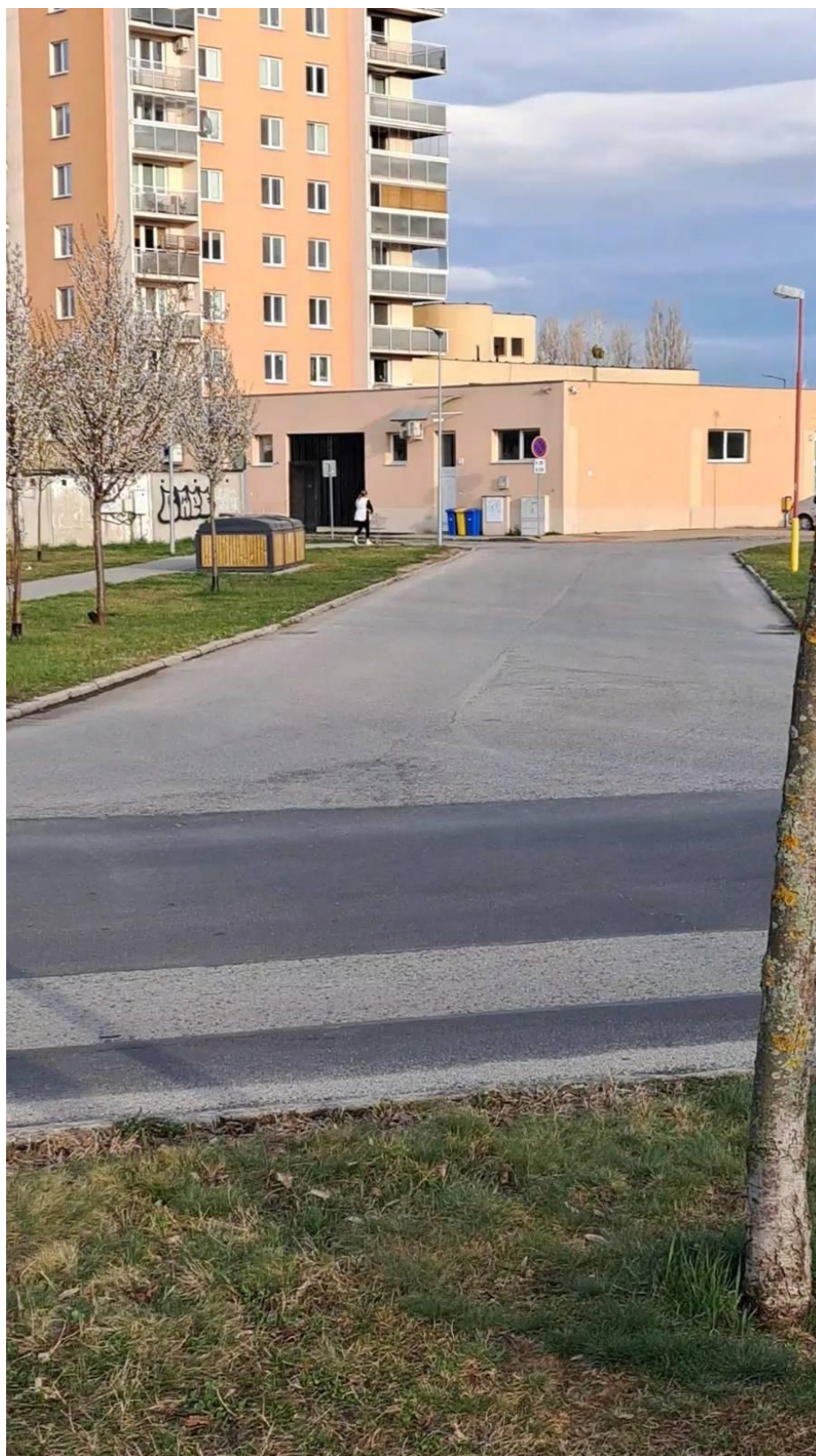
Polopodzemné kontajnery pri zadnom vchode do COOP Jednota
