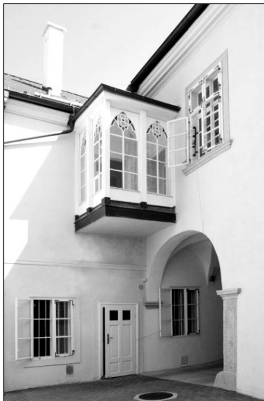
Arkier na dvore opraveného domu na Kapitulskej č. 19
