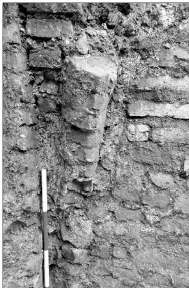
Detail nábehu klenbového rebra zloženého z tehlových tvaroviek, foto: A. Žitňan.
