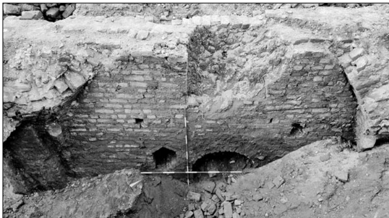
Pohľad na interiérny povrch severnej steny v rozsahu jedného klenbového poľa. V spodnej časti otvor s predpokladanou funkciou transportu sudov z terénu dvora, vľavo typická nika na položenie osvetľovacieho telesa ukončená strieškou, foto: A. Žitňan.
