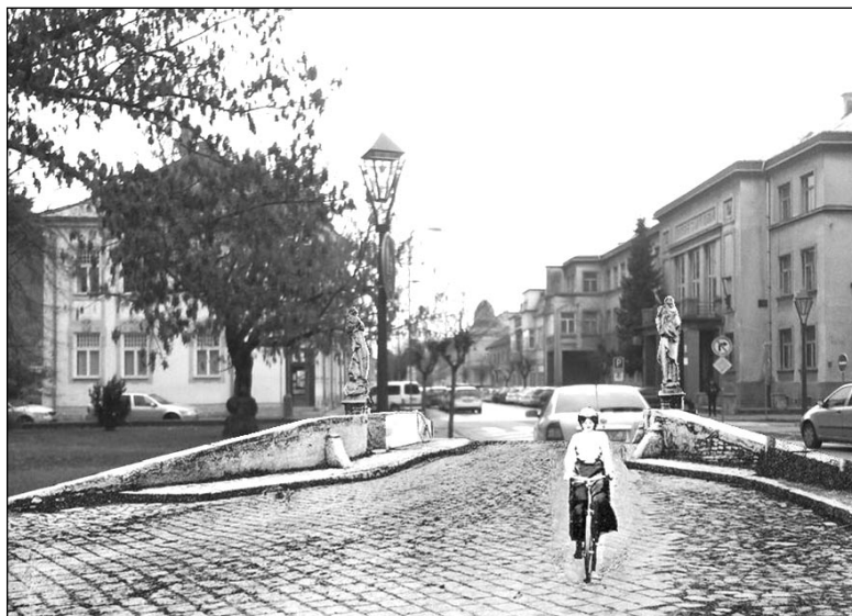
Barokový most cez Trnávku ešte pred jej prekrytím na dobovej pohľadnici okolo roku 1900 – 1910 (zdroj: Jozef Benko) vsadený do reálneho prostredia v roku 2017
