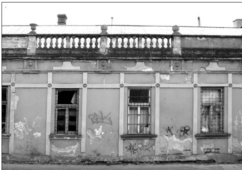
Výzdoba domu na Zelenom kričku, hornú časť fasády zdobí atika, v strede je kuželková balustráda a ozdobné prvky s motívom vazy, foto: autorka, 2017
