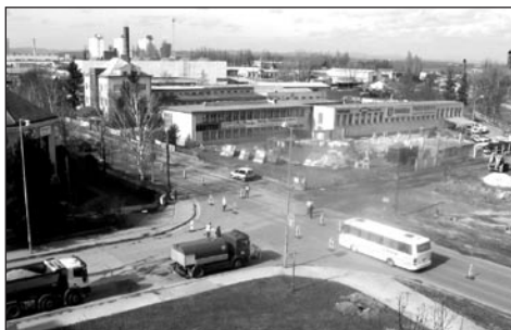
▲ Križovatka na Trstínskej pred rekonštrukciou
