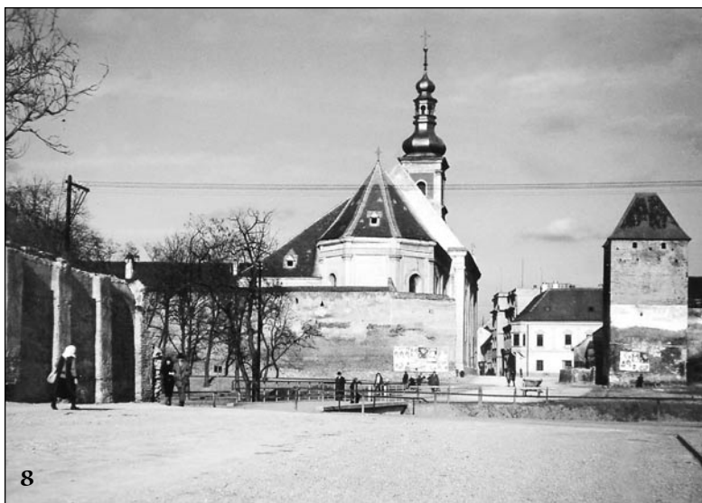
8 Stavba Bernolákovej brány, cesty a mostu okolo r. 1937
