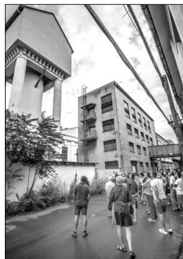
Trafostanica 4000 KWA pri elektrárenskom vodojeme počas prehliadky v roku 2017
