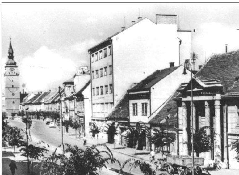
Pohľad na zástavbu Masarykovej ulice vedľa špitála okolo roku 1950, fotografia
