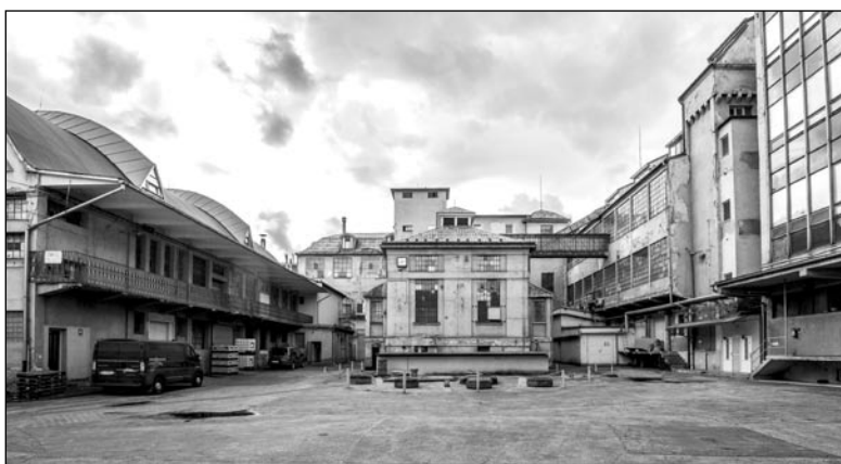
Pohľad na dvor. Vľavo sa nachádza sklad, v strede strojovňa a za ňou hlavná výrobná budova pokračujúca do krídla vpravo (zdroj: M. Beňák)
