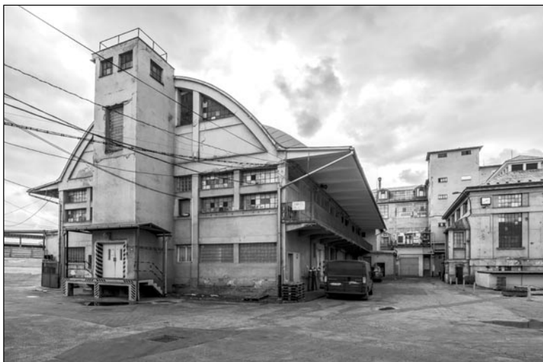
Budova skladu (zdroj: M. Beňák)
