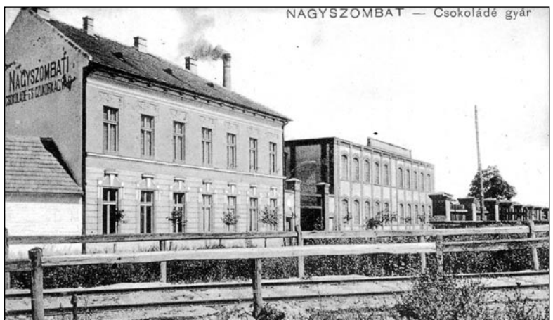
Továreň okolo roku 1915 na starej pohľadnici (zdroj: I.D.C. Holding)
