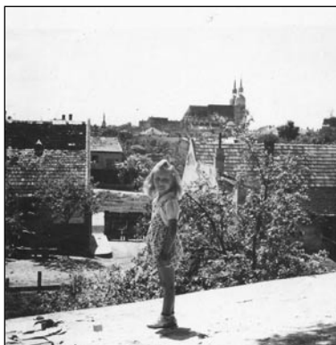
Pohľad na Trnavu od domu Michalčovských za Bučianskou cestou
