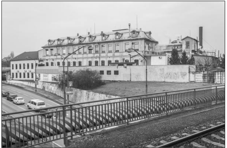
Pohľad na hlavnú výrobu od železnice (zdroj: M. Beňák)
