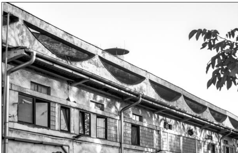
Detail „štítovej“ steny vytvorenej vlnkou škrupinovej strechy tvaru hyperbolického paraboloidu na južnej lodi (2017)
