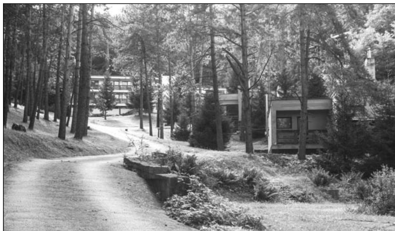
Areál rekreačného strediska Kovosmaltu (TAZky) na Dobrej Vode (autor, 2020)
