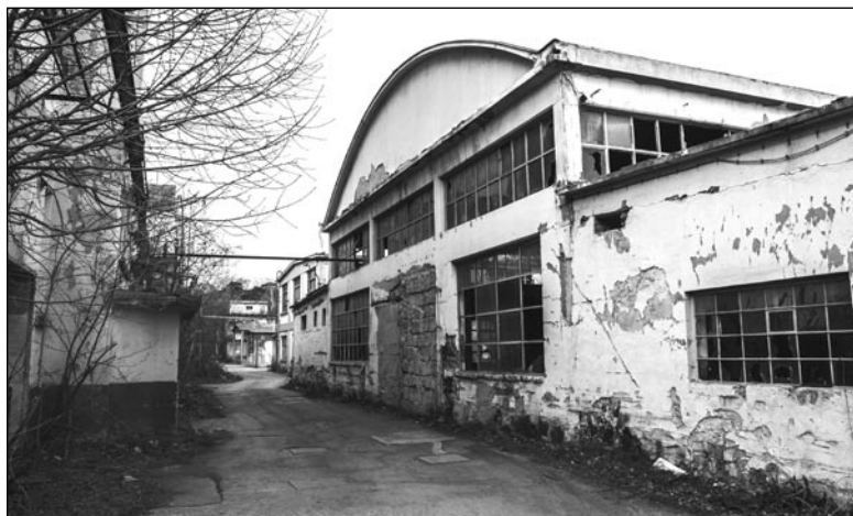
Stav budovy klinecovne pred rekonštrukciou (2016)
