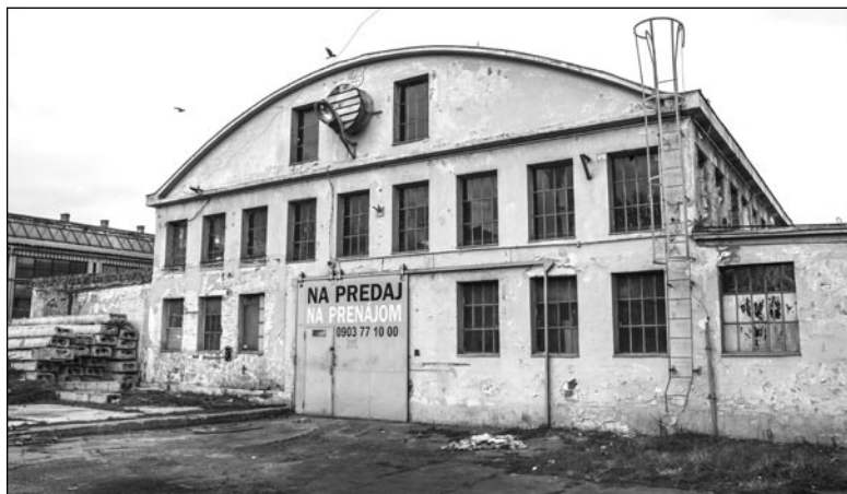
Budova na špeciálnu výrobu Banskej a hutnej spoločnosti pred rekonštrukciou (2016)
