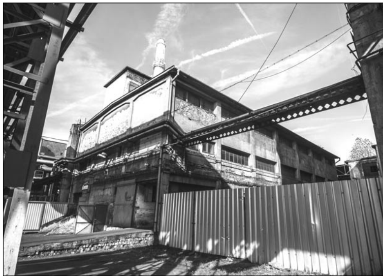
Železobetónový sklad za zlievarňou z roku 1929 (2019)
